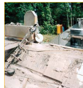
Канатный автомат CSA-1001 H при горизонтальной резке мостовой опоры
